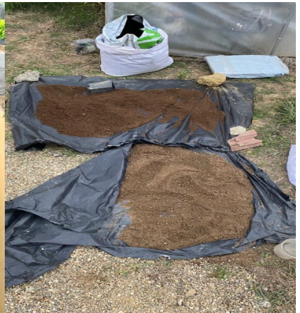
Görsel 3. Harç hazırlığı Image 3. Soil Mortar Preparation
