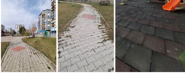
Şekil 48. Eyüp Sultan Parkı zemin döşeme elemanları Figure 48. Eyüp Sultan Park flooring elements
